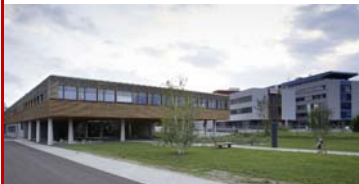
CTR Standort im High Tech Campus Villach
